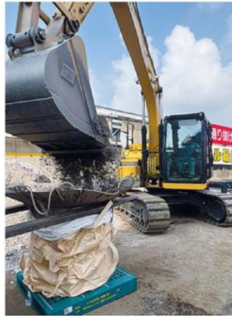
再生材のフレコンへの封入状況
